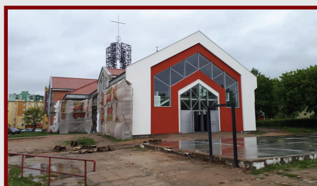
2019.04 Prace przy elewacji
